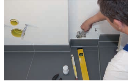
Die Sanierung der Sanitäranlagen in Sporthallen können sich bezahlt machen.
