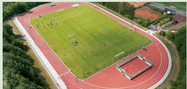
*Sanierung des Kunststoffbelags des Wasgaustadions in Hauenstein mit Neubau eines Kleinspielfeldes in einem Segment, einer Kugelstoßanlage und einer Weitsprunggrube. Weiterhin wurde die Flutlichtanlage auf LED-Strahler umgestellt und die Beregnungsanlage des Naturrasenplatzes erneuert.*
