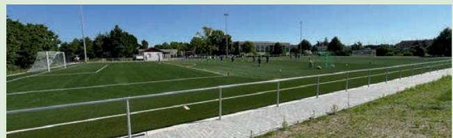
*Neubau eines korkverfüllten Kunstrasenplatzes an der Horstringsschule in Landau mit einem Umgangsweg aus Betonpflaster, Neubau einer 6-Mast-Flutlichtanlage (LED) und eines Ballfangzaunes sowie Einbau einer Barriere.*
